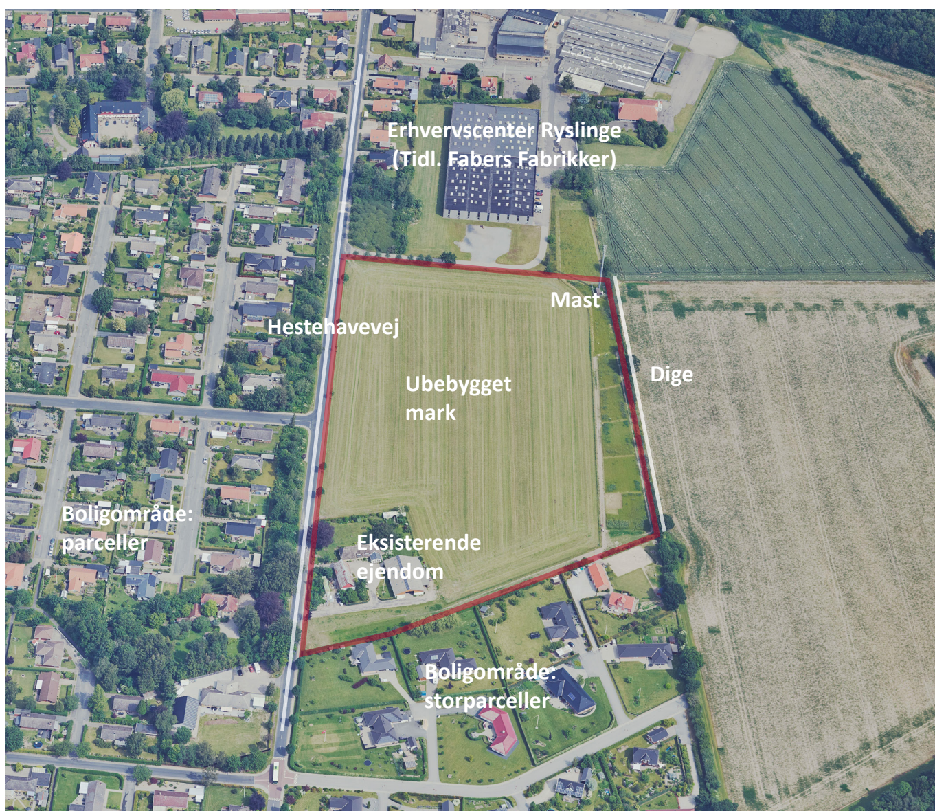
Luftfoto over lokalplanens område.
